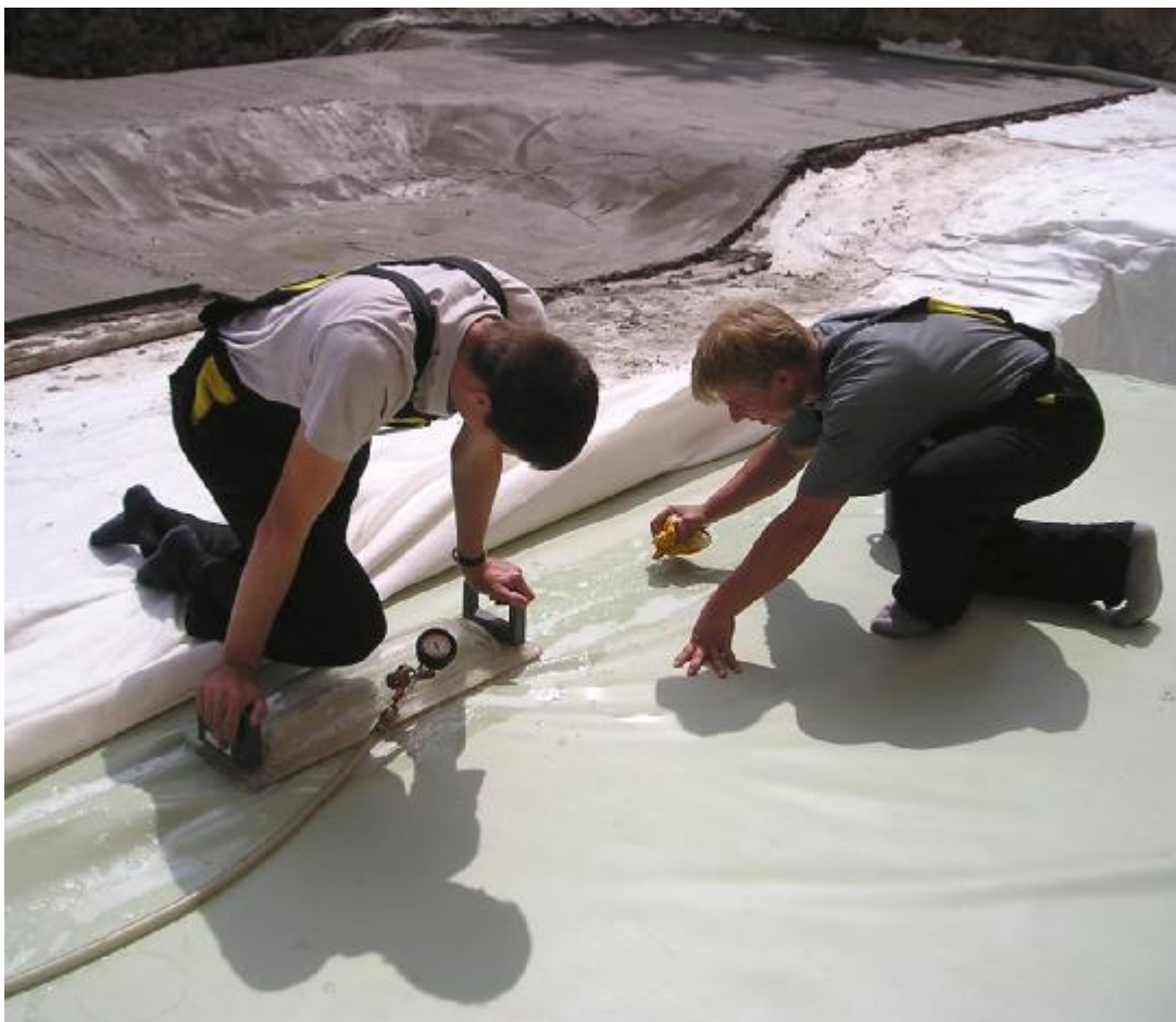
Foto 3. Zkoušení těsnosti spojů vakuovou zkouškou.
