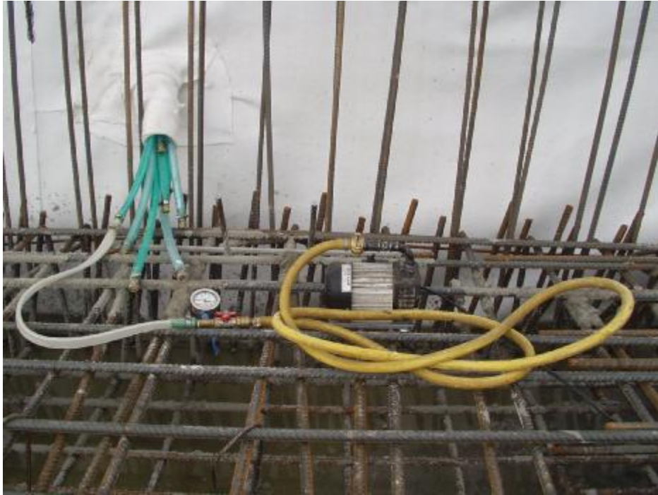
Foto 5. Kontrola těsnosti sektorové hydroizolace po provedení výztuže.
