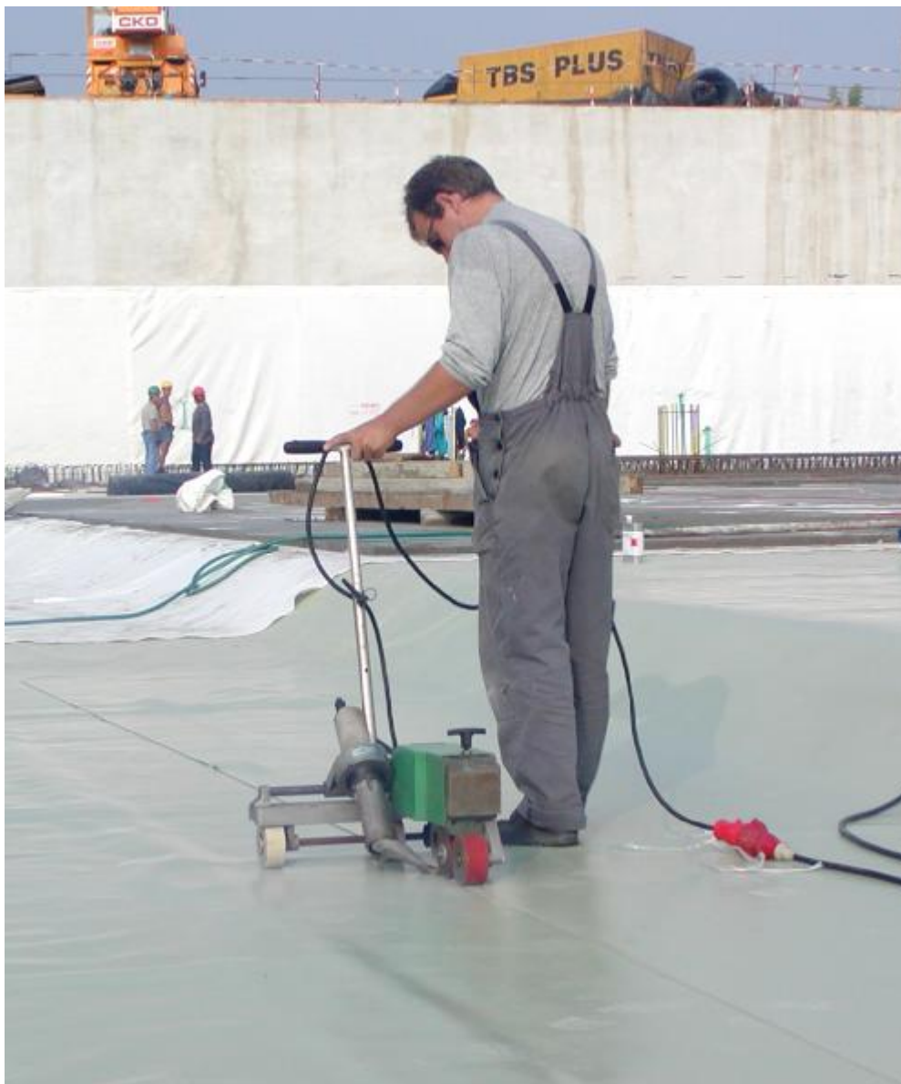
Foto 2. Práce se svařovacím automatem LEISTER VARIMAT.
