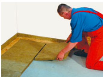
Pokládka izolace Steprock HD (obr. 17)
