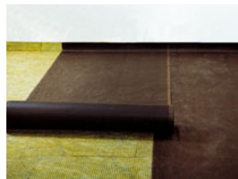
Pokládka hydroizolační vrstvy (obr. 5)
