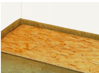
Okrajový pásek Steprock a první roznášecí vrstva (obr. 18)
