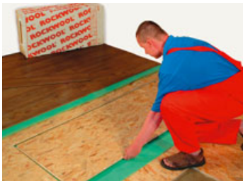
Pokládka druhé roznášecí vrstvy (obr. 19)
