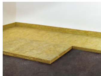
Pokládka desek Steprock ND (obr. 4)
